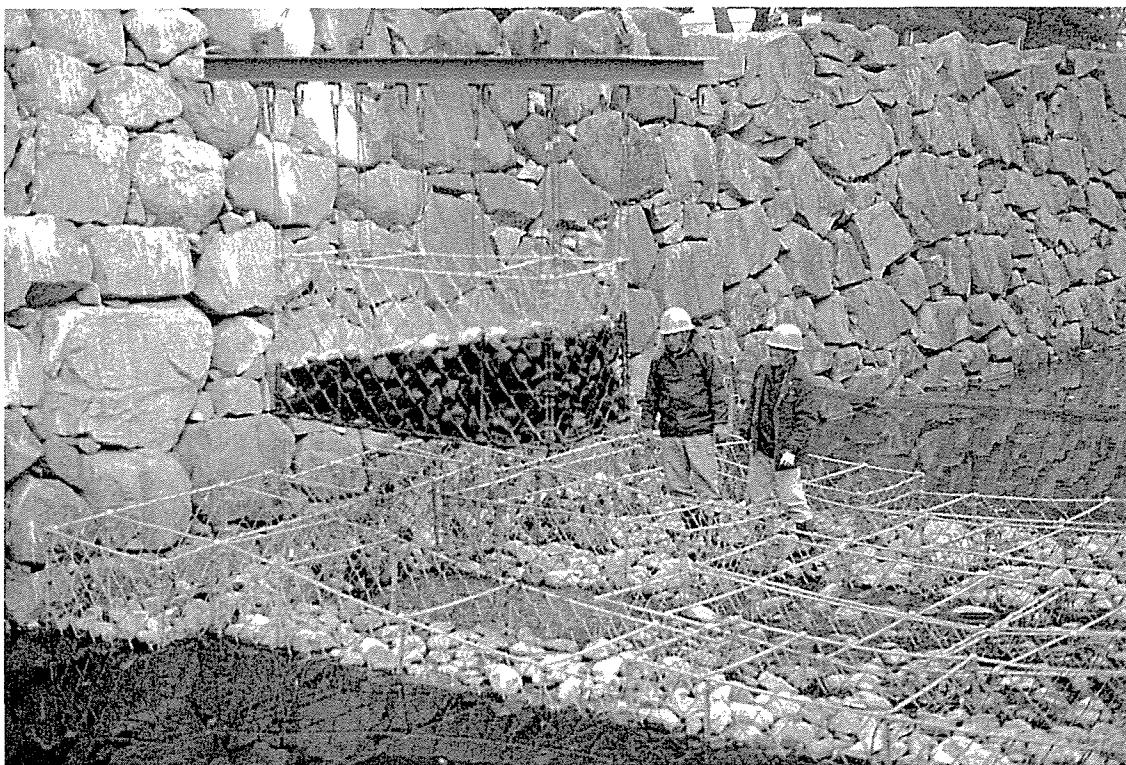
図版4. D濠に設置された礫閃浄化装置
