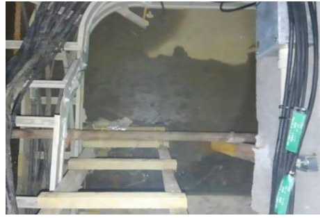
写真13 堅穴 P13と P14の間に位置する研究棟 地下に水が染み出ている様子(2017.5)
