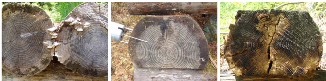
図 - 1. 2 木堰堤部材における辺材部の腐朽の様子 (左：3年経過の浪合，中：7年経過の内山3，右：7年経過の中条)
