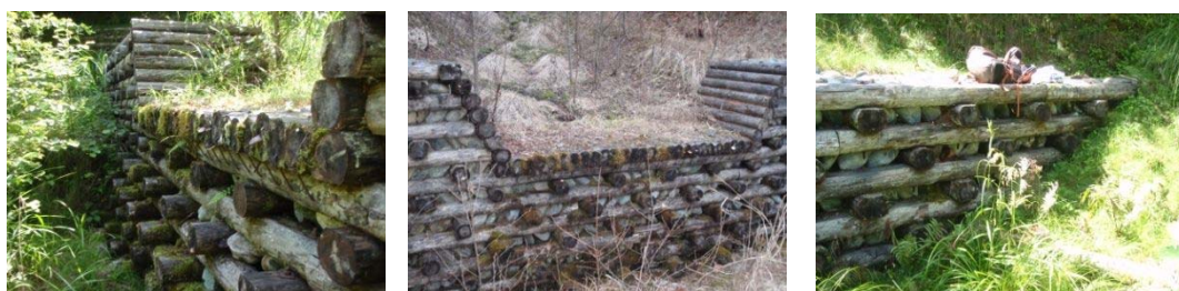
図 - 2. 23 伊那市高鳥谷の木堰堤（カラマツ材）：2012 年 4～8 月撮影 7 年経過
