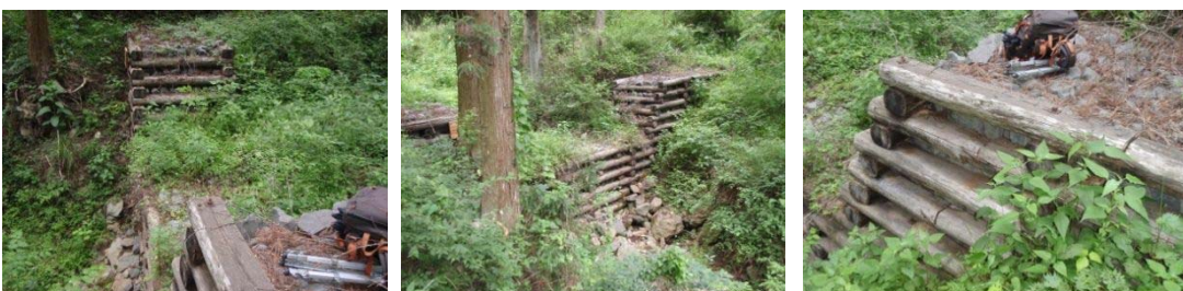
図 - 2. 5 上田市虚空山の木堰堤（カラムツ材）：2012 年 6 月撮影 7 年経過
