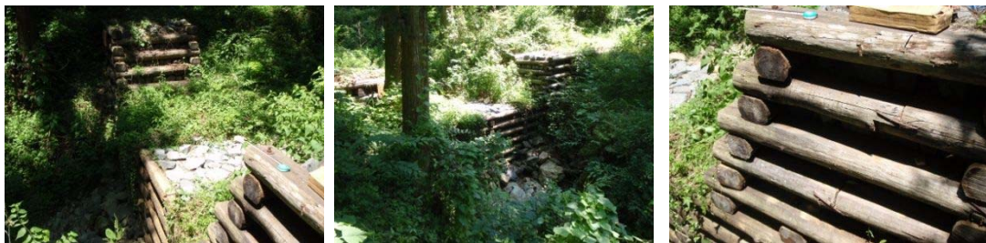
図 - 2. 4 上田市虚空山の木堰堤（カラムツ材）：2010 年 7 月撮影 5 年経過
