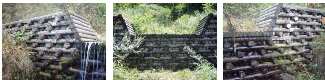
図 - 2. 21 伊那市高鳥谷の木堰堤（カラマツ材）：2007 年 8～11 月撮影 2 年経過
