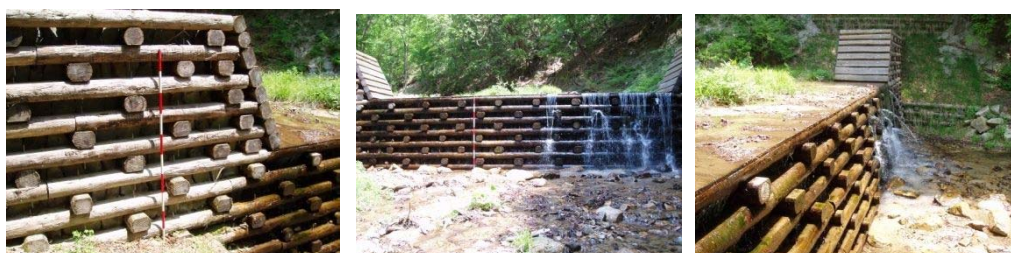
図 - 2. 35 阿南町門原の木堰堤（カラマツ材）：2007 年 5 月撮影 2 年経過
