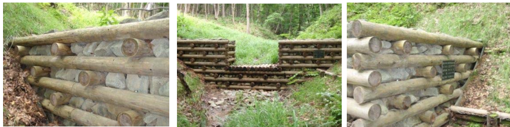
図 - 2. 37 中泊町大沢内の木堰堤（スギ材）：2008 年 8 月撮影 2 年経過
