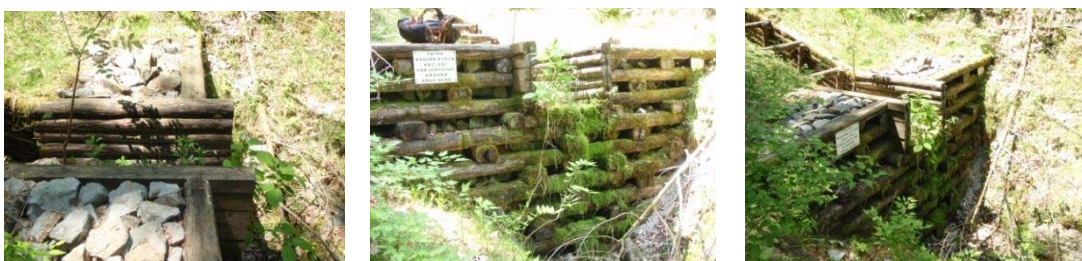
図 - 2. 27 木曽郡上松町の木堰堤（カラマツ材）：2012 年 5 月撮影 6 年経過
