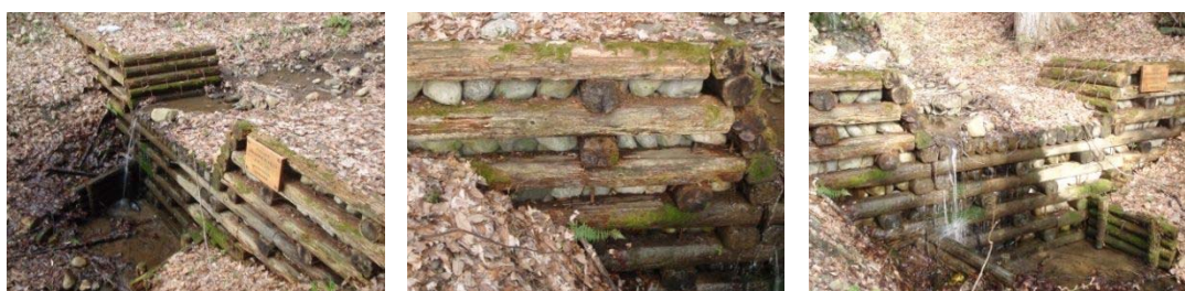
図 - 2. 20 伊那市田原の木堰堤（カラマツ材）：2013 年 4 月撮影 9 年経過
