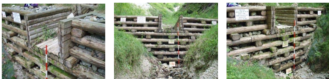
図 - 2. 25 木曽郡上松町の木堰堤（カラマツ材）：2007 年 8 月撮影 1 年経過
