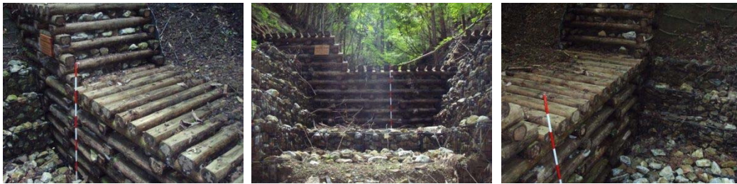
図 - 2. 9 波田町荒倉の木堰堤（カラマツ材）：2007 年 9 月撮影 1 年経過
