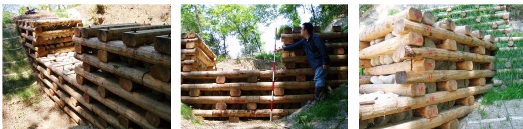
図 - 2. 6 安曇野市中条の木堰堤（カラマツ材）：2006 年 5 月撮影 1 年経過
