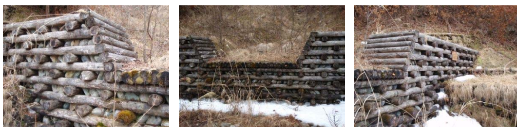
図 - 2. 22 伊那市高鳥谷の木堰堤（カラマツ材）：2010 年 4 月撮影 5 年経過
