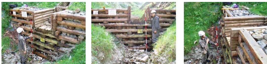
図 - 2. 24 木曽郡上松町の木堰堤（カラマツ材）：2006 年 10 月撮影 0 年経過
