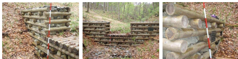
図 - 2. 38 中泊町大沢内の木堰堤（スギ材）：2009 年 5 月撮影 3 年経過
