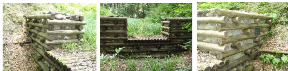
図 - 2. 40 中泊町大沢内の木堰堤（スギ材）：2011 年 8 月撮影 5 年経過
