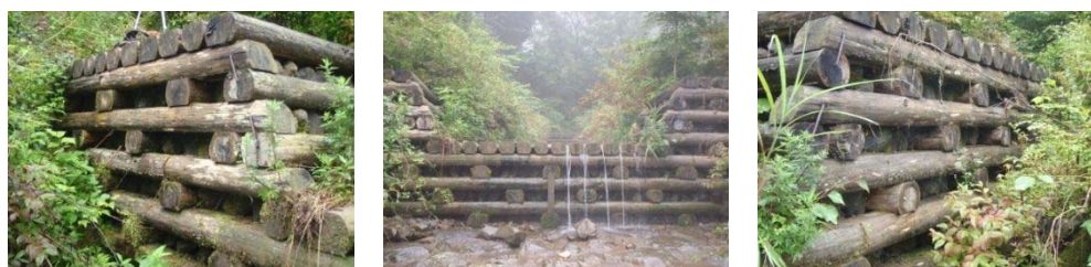
図 - 2. 46 富士宮市主水釣の木堰堤（スギ材）：2012 年 7 月撮影 4 年経過
