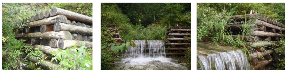
図 - 2. 45 富士宮市主水釣の木堰堤（スギ材）：2011 年 8 月撮影 3 年経過
