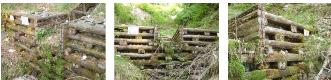
図 - 2. 26 木曽郡上松町の木堰堤（カラマツ材）：2011 年 5 月撮影 5 年経過
