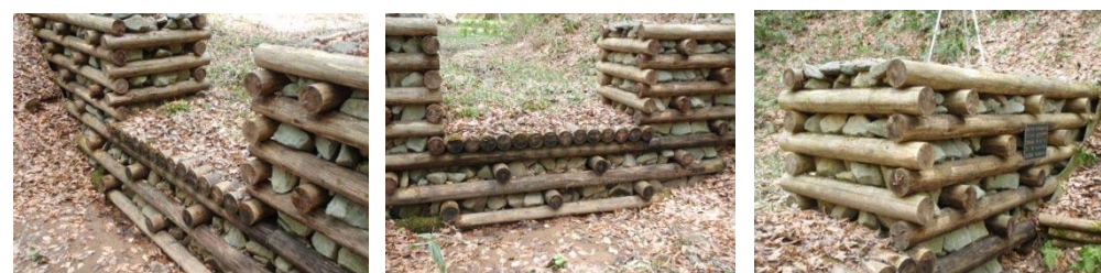
図 - 2. 41 中泊町大沢内の木堰堤（スギ材）：2012 年 5 月撮影 6 年経過
