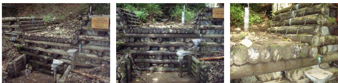
図 - 2. 19 伊那市田原の木堰堤（カラマツ材）：2007 年 10 月撮影 4 年経過
