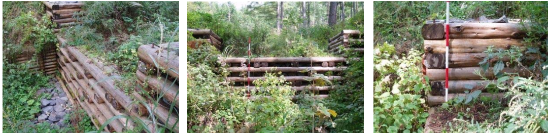
図 - 2. 2 中野市前平の木堰堤（スギ材）：2006 年 10 月撮影 3 年経過
