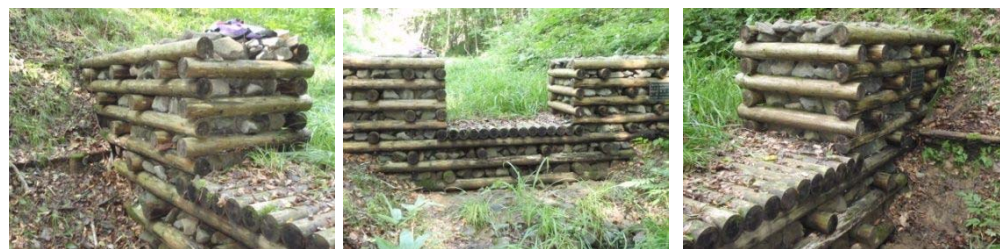
図 - 2. 39 中泊町大沢内の木堰堤（スギ材）：2010 年 8 月撮影 4 年経過
