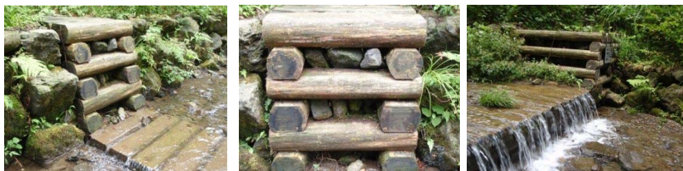
図 - 2. 42 富士宮市主水釣の木製流路工（スギ材）：2009 年 8 月撮影 0 年経過
