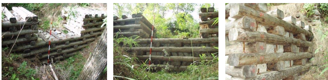
図 - 2. 7 安曇野市中条の木堰堤（カラマツ材）：2007 年 9 月撮影 2 年経過
