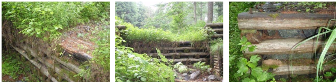
図 - 2. 3 中野市前平の木堰堤（スギ材）：2012 年 7 月撮影 9 年経過
