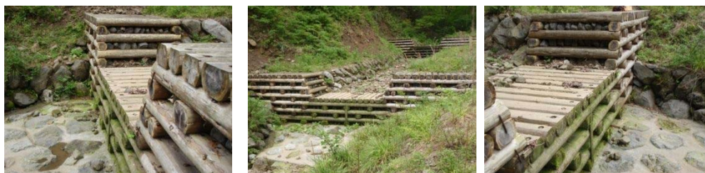
図 - 2. 44 富士宮市主水釣の木堰堤（スギ材）：2010 年 5 月撮影 2 年経過
