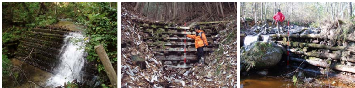
図 - 1. 1 昭和年代に施工された木堰堤の様子 (左：青森県坪毛沢流域，中：長野県南木曾町，右：長野県御岳山)
