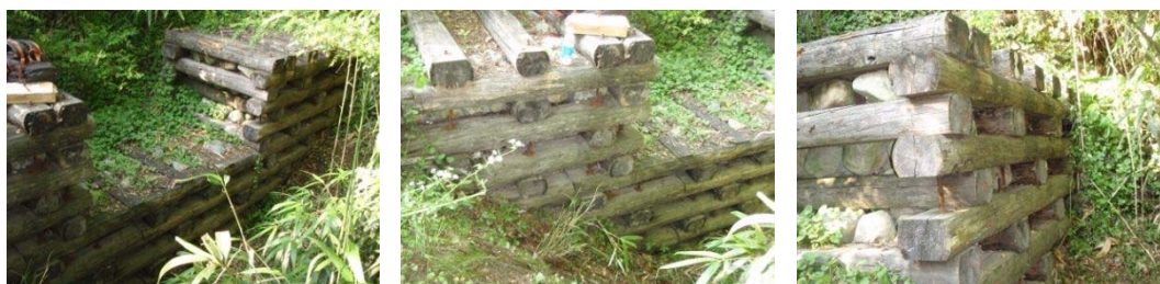
図 - 2. 8 安曇野市中条の木堰堤（カラマツ材）：2011 年 7 月撮影 5 年経過
