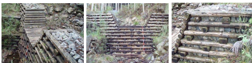
図 - 2. 36 根羽村浅間の木堰堤（スギ材）：2007 年 11 月撮影 3 年経過
