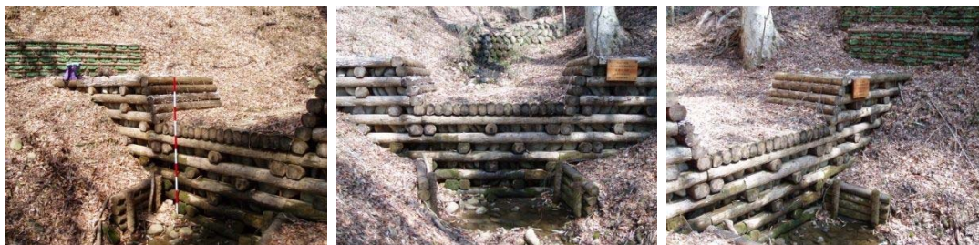
図 - 2. 18 伊那市田原の木堰堤（カラマツ材）：2006 年 4 月撮影 3 年経過
