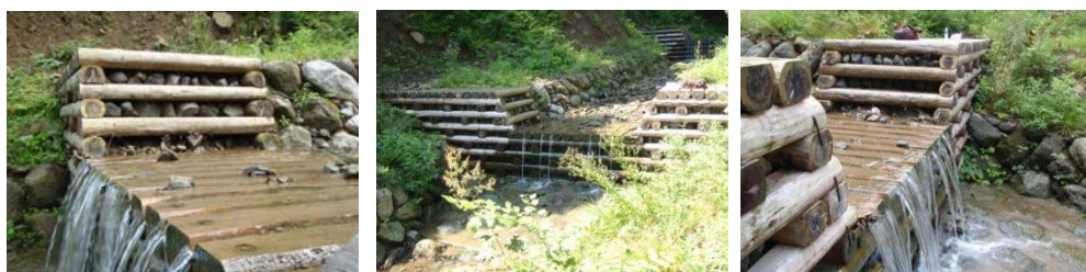
図 - 2. 43 富士宮市主水釣の木堰堤（スギ材）：2009 年 8 月撮影 1 年経過
