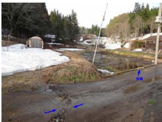
写真3 上田小池の道路変状 写真奥から手前へ直線状の谷が連続する。谷を横切る路面に短縮破壊が見られるが、亀裂や変形は路面のみで亀裂の走向方向へはほとんど連続しない(図2 地点B)
