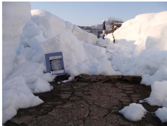
写真2 宮野原断層の撓曲崖に見られた路面の圧縮破壊 写真中央の路面の高まりは、奥から手前へのし上げている(図2 地点A)
