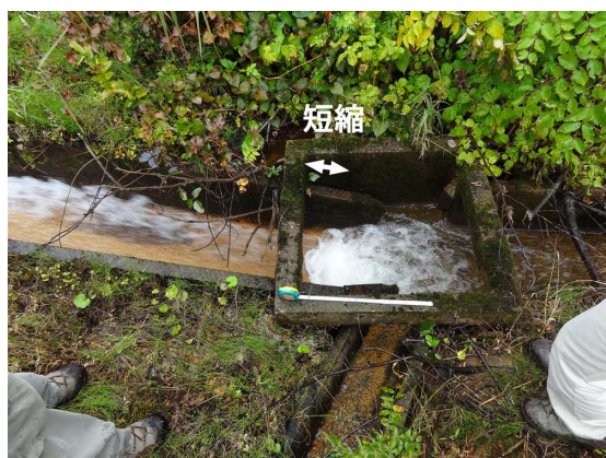
写真4 地盤の短縮で奥へずれ込んだコンクリート製の用水路 写真左が斜面側で、上流側には座屈変形が続く(写真外)(図3 地点C)
