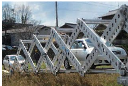
(c) 車両用実験橋 (全長 20.1m)
