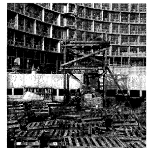
写真-11 77) 日本からの石を立てる。蓬莱の部分。
