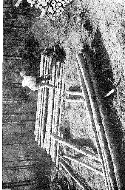
8 玉切られた間伐材は、長さ、径級に仕分けられて山土場に仮極積されてゆく。
