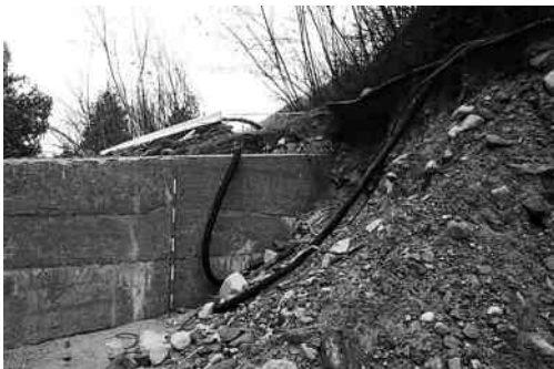
g. 砂防ダム下流園地入口の断崖
