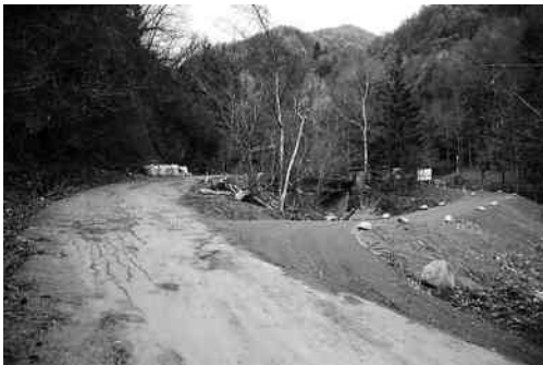
c. 桂小場橋付近 (下流側に迂回路設置)
