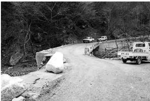
e. 広小橋 (発電所側)
