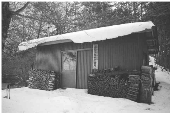
写真1 西駒演習林管理所 (ヒノキ小屋) 2008年12月撮影。
