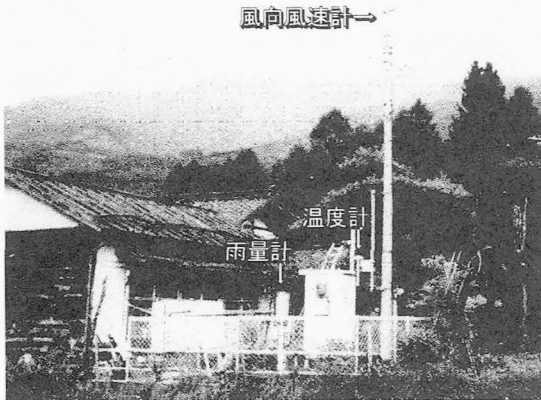
図15 AMeDAS4要素観測所の例 長野県南安曇郡奈川村 奈川地域気象観測所
