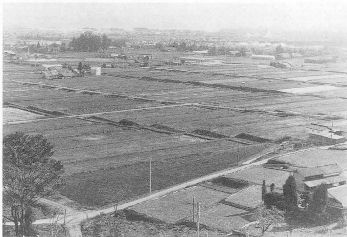
写真4・1 長方形区画Bによる整備(長野県宮田村北割地区)
