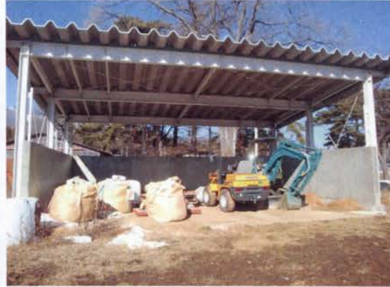
写真4 構内農場に新設された堆肥舎
