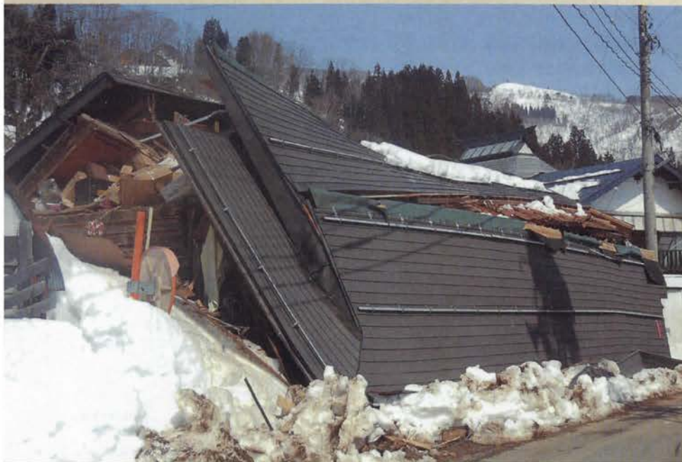
被害が大きかった栄村青倉地区。写真は全壊した青倉公民館
