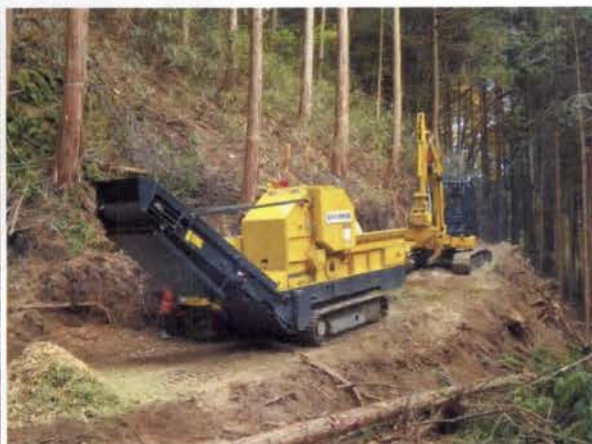
写真 2 作業道上でのチップ化作業
