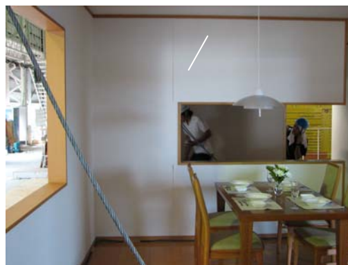
写真 4.4.1-2 クロスの破れ (LDK 部分)
