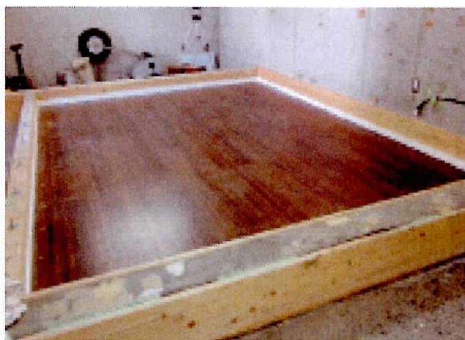
図 3-4 実験室における試験体の施工状況
