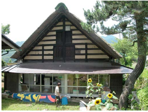
Fu01 三枝行雄家主屋を東からみた外観
