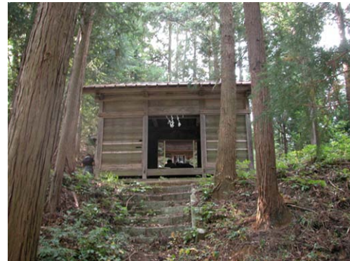
Fu07 若宮八幡宮拝殿を東からみた外観
