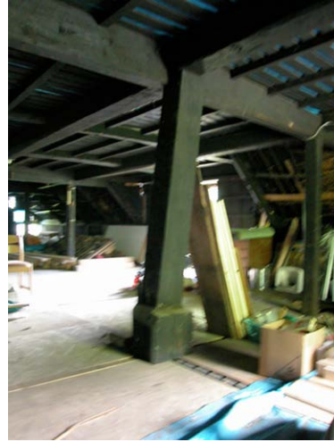
Fu04 淡路栄家主屋の2階からみた大黒柱
