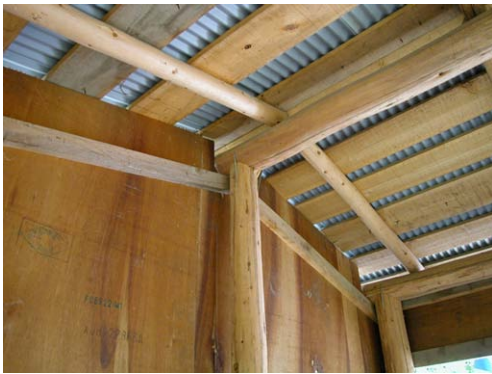
Fu14 直売所 棟持柱と棟木の接合部
