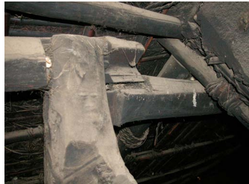
Fu20 藤原達男家主屋 大黒柱と棟木の接合部
