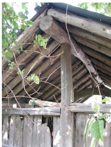
As01 棟持柱と棟木の納まり
