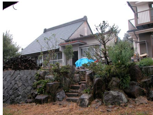
Fu21 赤池栄人家住宅を東からみた外観
