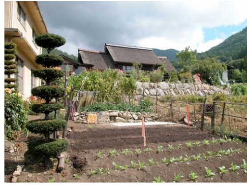
Fu01 三枝行雄家主屋を南からみた外観
