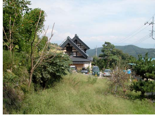
Fu16 高原左門家主屋を西からみた外観
