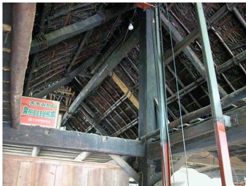
Fu06 古屋茂富家主屋の2階からみた大黒柱
