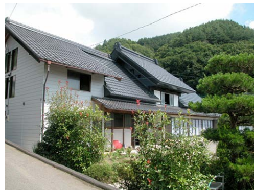
Fu17 山下政英家主屋を南からみた外観
