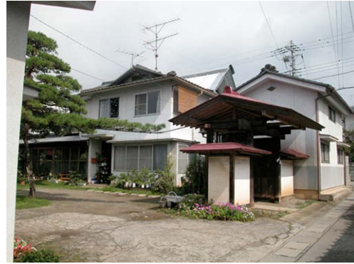
Fu24 宮原久巳家住宅を南東からみた外観
