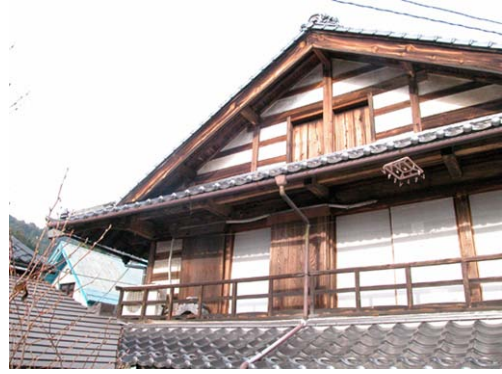
Fu19 妣田圭子家主屋を北東からみた外観
