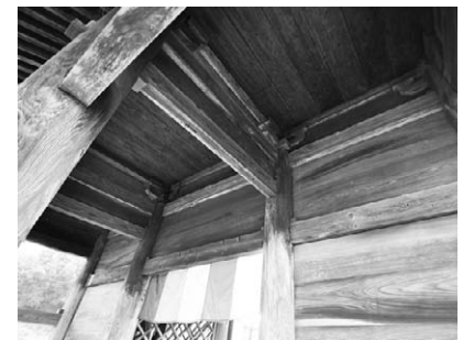
写真 2 観音寺仁王門 通路上部
