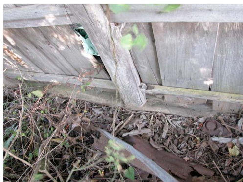
As01 棟持柱と土台の納まり
