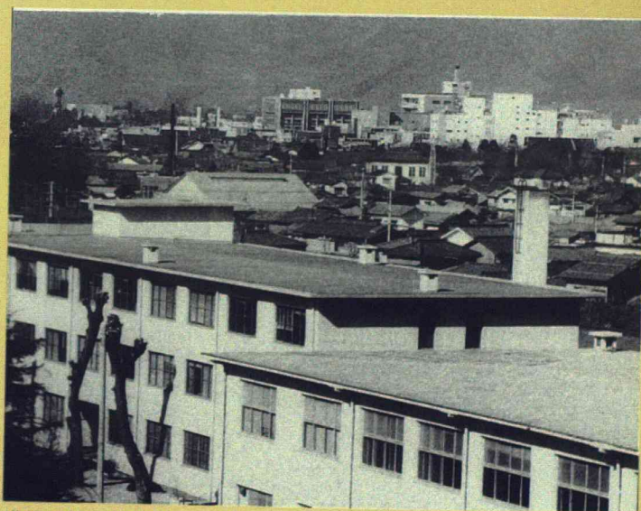
繊維機械学科棟越しに見る上田市内 遠くに市役所ビルも見える (昭和46年)
