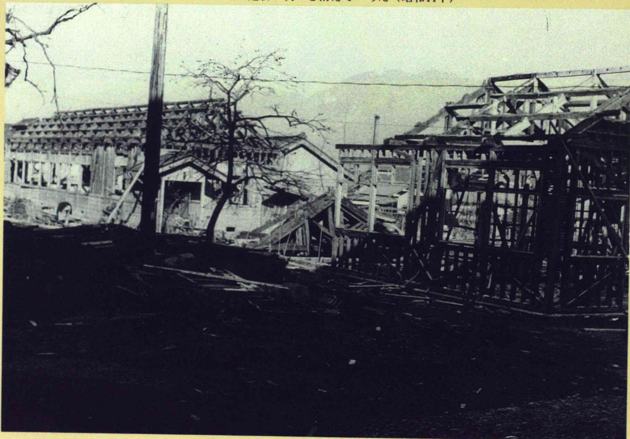
蚕体病理実験棟のとりこわし 散在していた旧建物が次々と消えていった（昭和44年）
