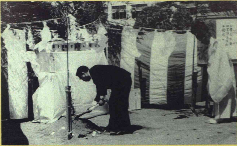
研究棟新営搬入れ式 繊維工業化学科研究棟 新営のための搬入れ式 (昭和42年)
