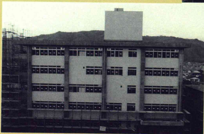
高分子棟完成間近 （昭和53年）
