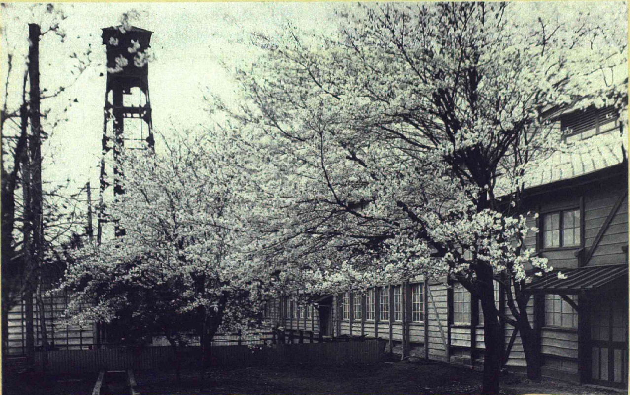
製糸工場及び貯水タンク (昭和初期)
