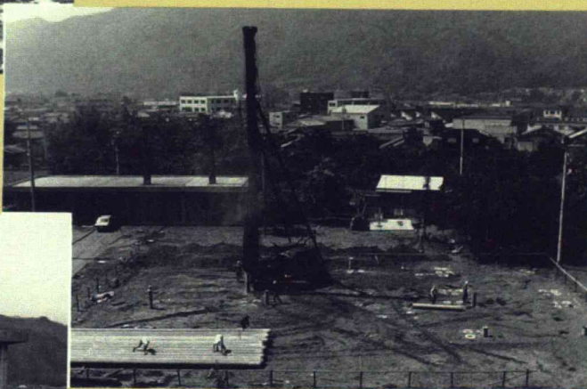
高分子棟基礎工事 （昭和53年）
