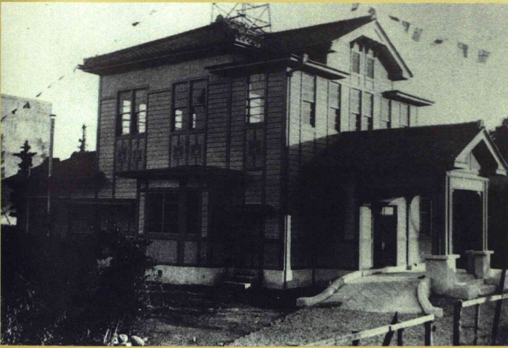
旧千曲会館：創立25周年記念竣工（昭和10年）
