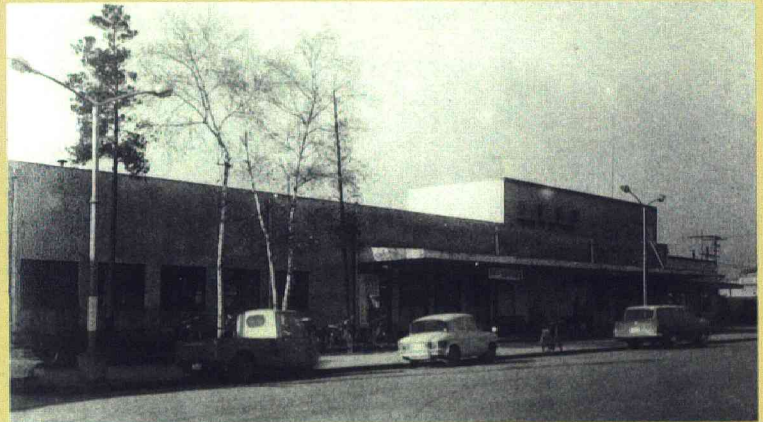
上田駅 改築当時 (昭和40年)
