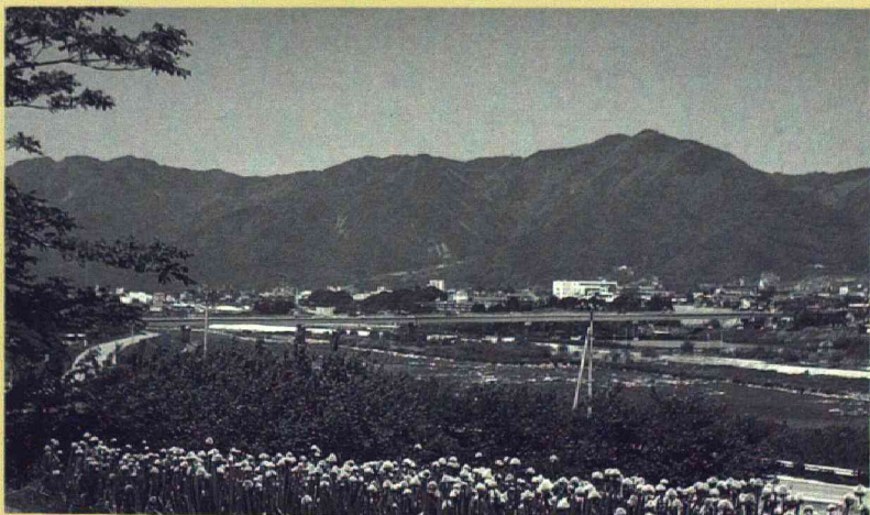
小牧橋 川西線の交通渋滞解消 のため上田橋上流にかけられた (昭和63年)
