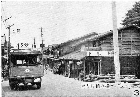
写真3 三条市島田の虫害発生箇所とその環境
