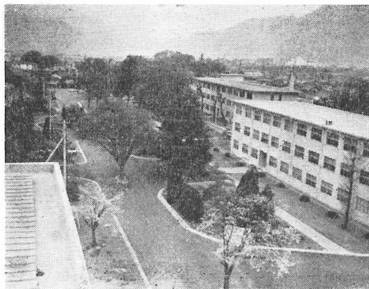
構内道路補装完成した学園
