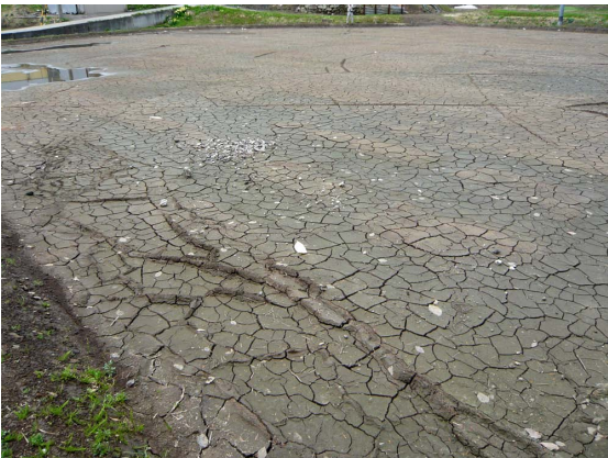
写真 14 リッジが多数生じた水田（横倉地区）
