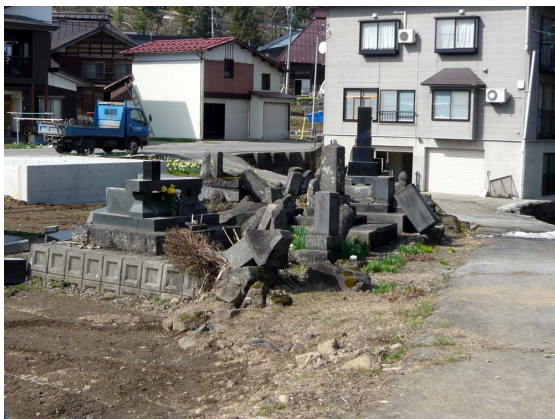
写真5 青倉地区における墓石の転倒
