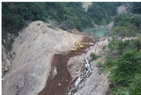
図6 崩落した岩盤が中条川をせき止めている様子 2011年8月30日撮影
