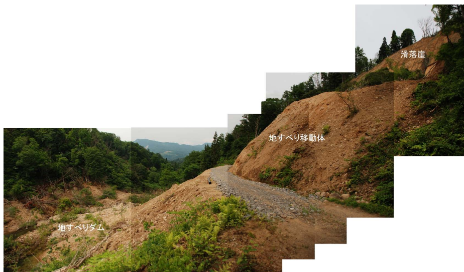
写真 5 奈免沢川崩壊性地すべり B の全景 (2011 年 6 月 20 日)
