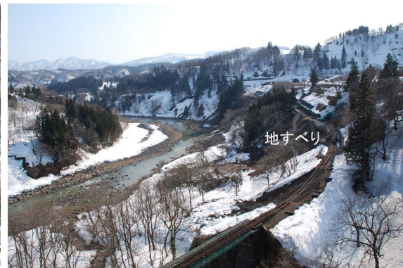
写真11 飯山線の被災箇所 (2011年4月4日)
