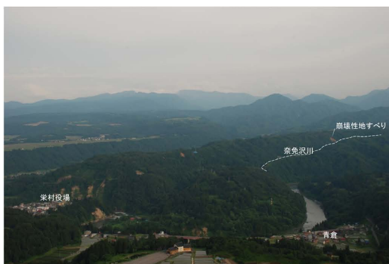
写真 6 奈免沢川崩壊性地すべり B の遠景 (2011 年 6 月 19 日)
