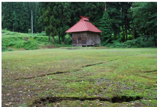
写真1 小滝集落のお宮と境内の被害状況（手前は地震による亀裂）
