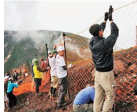
図12 ボランティアによる防護柵設置作業
