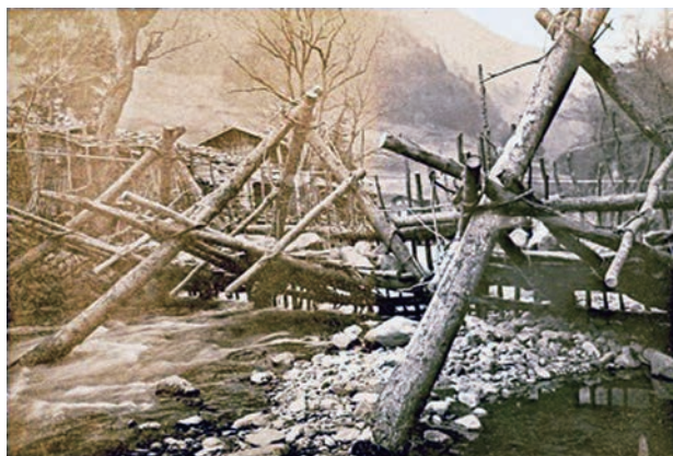
図9 流送された薪材の引き上げのための装置 (近景)
