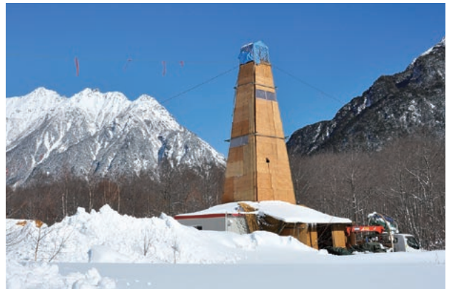
写真 2 厳冬期に行われた掘削作業 (09 年 2 月撮影)
