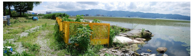
(c) 施工後496日 (2009/7/23)
