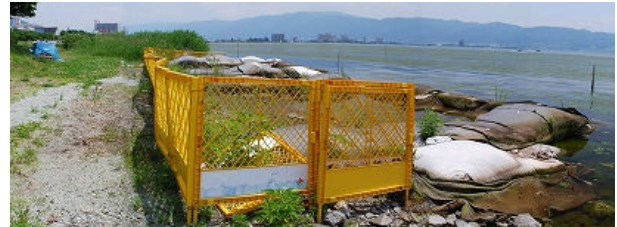
(b) 施工後462日 (2009/6/19)
