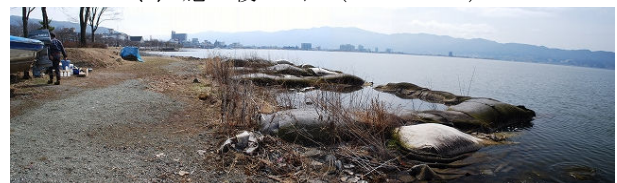
(f) 施工後718日 (2010/3/2)
