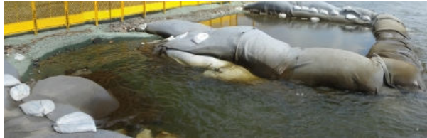
(n) No.6の状況 (2008/4/14)
