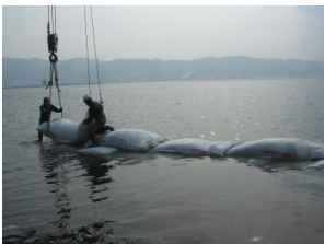
写真-21 2段目土嚢の設置
