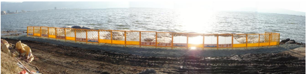
写真-34 侵入防止柵の設置
