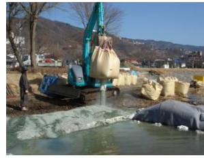
写真-31 湖岸への敷設
