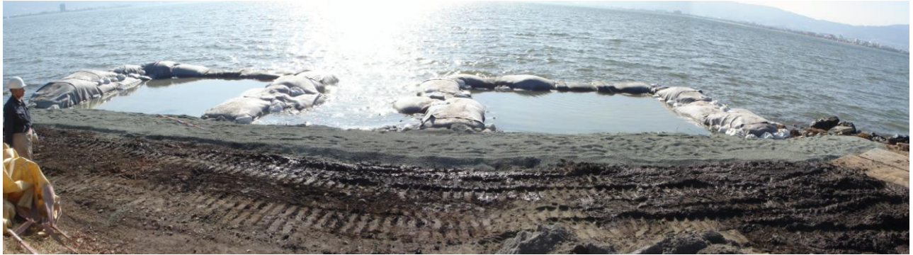
写真-33 施工完了後の全景 (2008年3月15日)
