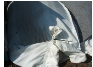
写真-16 結束バンドによる試料投入口の密封
