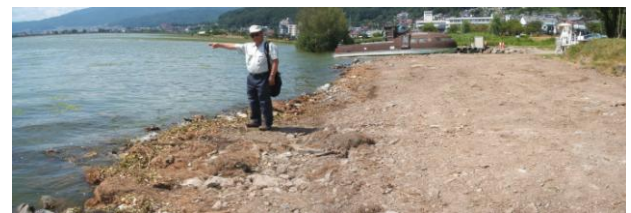
写真-3 施工箇所の状況 (2007年8月17日)
