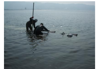
写真-20 透水シートの設置
