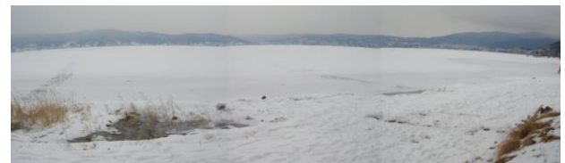
写真-4 施工箇所の状況 (2008年2月6日)
