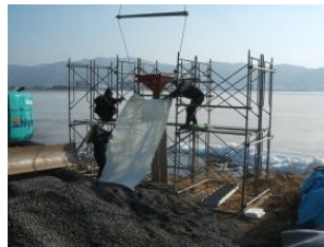
写真-14 大型土嚢の足場への設置
