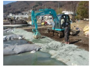
写真-32 バックホウによる敷き均し
