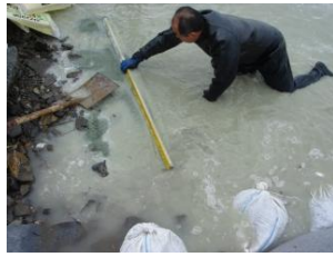
写真-30 潜水士による敷き均し
