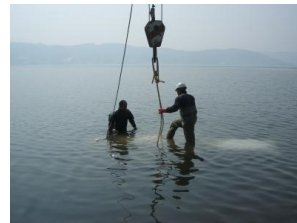
写真-19 1段目土嚢の設置
