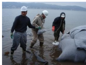
写真-26 土嚢（玉砂利）による透水シートの固定
