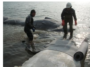
写真-23 透水シートの設置
