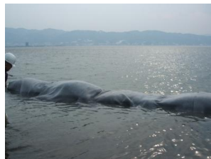
写真-22 透水シートの巻込み
