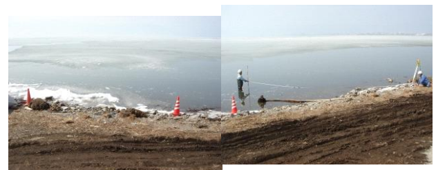
写真-5 施工箇所の状況 (2008年3月12日)
