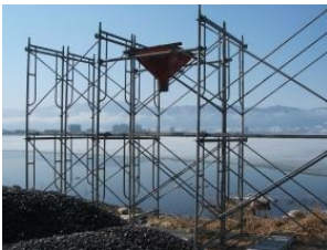
写真-13 袋詰め作業用足場
