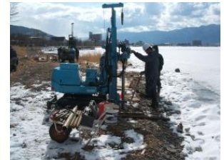
写真-7 ボーリング調査の状況(1)
