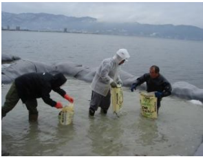
写真-29 圍繞堤内への敷設
