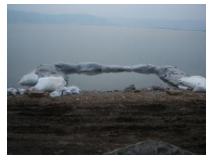
写真-27 囲繞堤の施工完了（ケース1）
