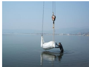
写真-18 土嚢の吊り下げ(2)
