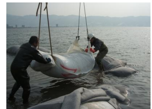
写真-24 2段目土嚢の設置
