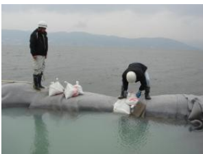
写真-25 低い部分を土嚢（天然ゼオライト）で嵩上げ
