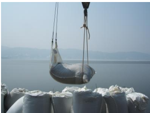
写真-17 土嚢の吊り下げ(1)
