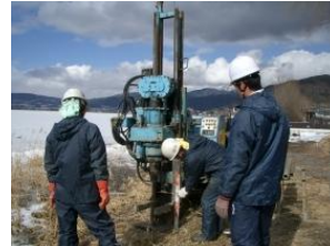
写真-8 ボーリング調査の状況(2)
