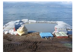
写真-28 囲繞堤の施工完了（ケース2）
