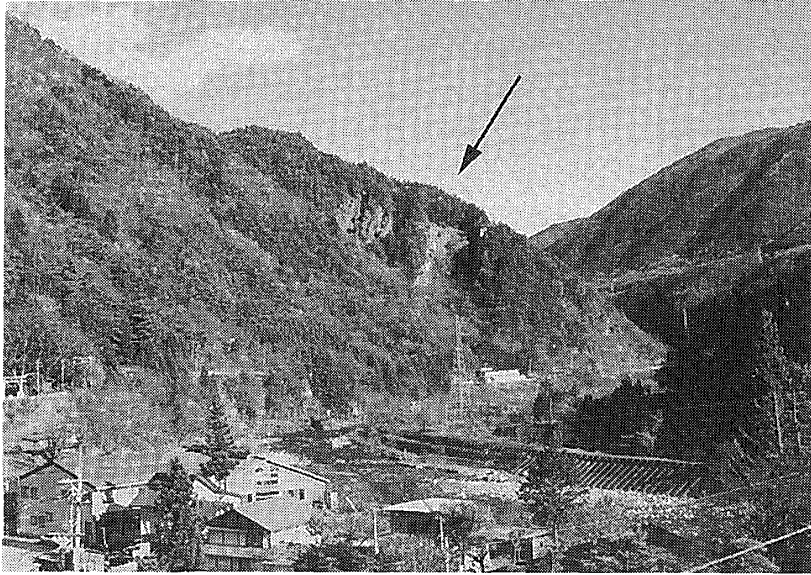
第6図 野沢「たかつなぎ」 矢印が崩壊地を示す。右側の崩壊地が1945年に新たに形成された。
