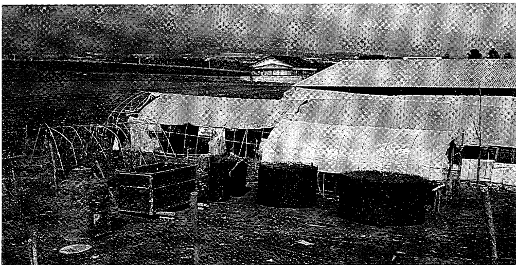
写真-2. 熟成槽の設置状況
