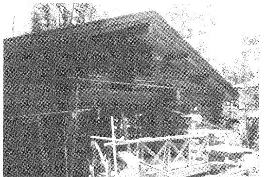
写真一14 建設中のログハウス
