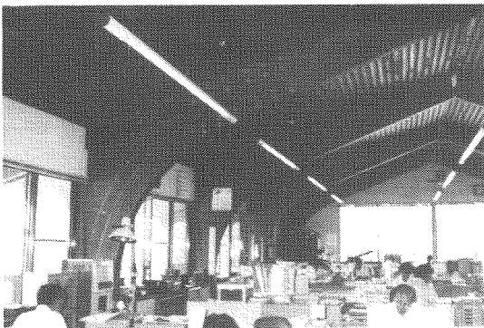
写真-8 大断面集成材の梁 (上田営林署)
