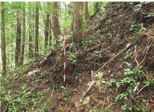
図9 城山西側の東側隆起に伴う撓曲(地点③) 山側の隆起量は最大 80 cm におよび亀裂が断続的 に見られる.
