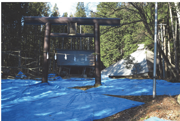
図27 城嶺神社敷地の変状
