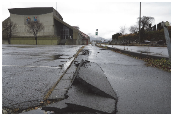
図21 歩道の圧縮変形(図18の③)
