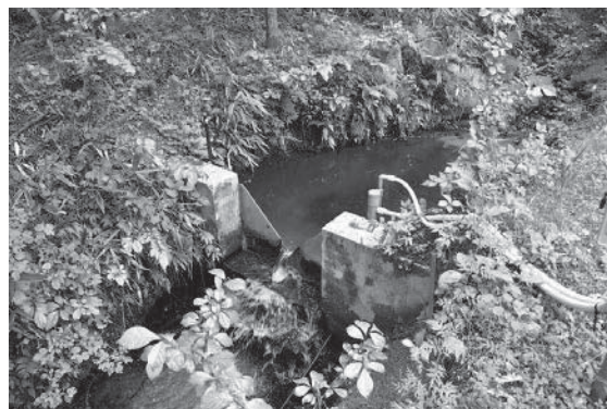
写真1(b) 量水堰(下流側から撮影)
