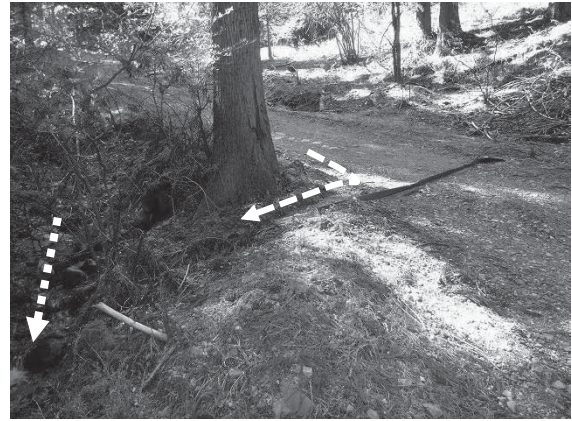
写真6 路面から流路に水と土砂が流れ込む経路
