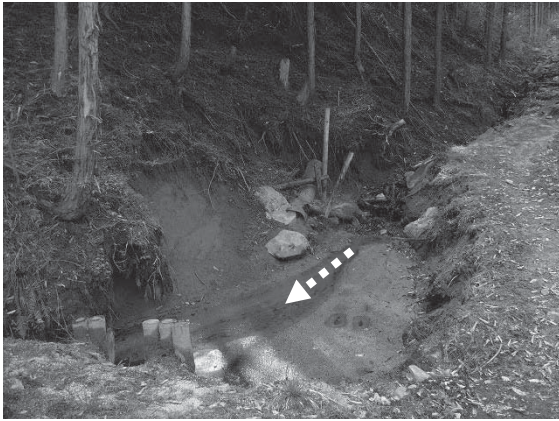
写真5(a) 溪岸崩壊と不安定土砂の堆積
