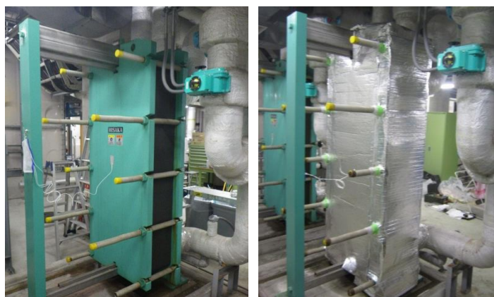
写真 5-7 水熱交換器の施工状況 (左：断熱前 右：断熱後)
