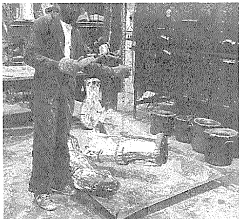
⑲ 型の中から蠟を戻す作業をスムーズに行うために、チェーンブロックで型の中央を吊り上げる。
