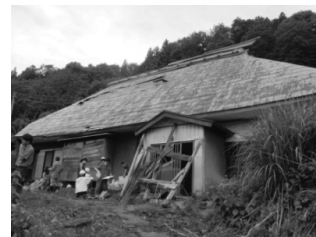
写真1 解体前の調査対象住宅外観
