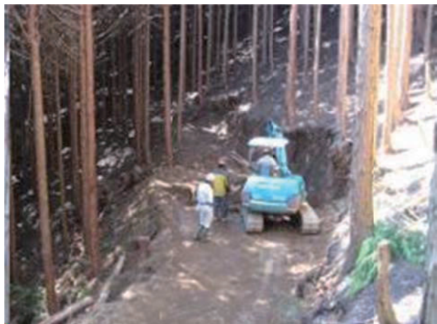
図-37 バックホウによる路網開設作業
