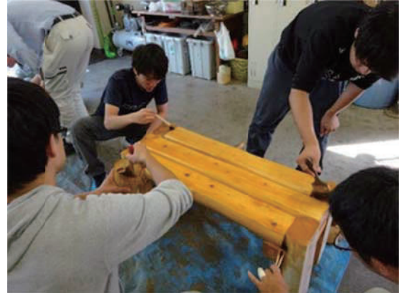
図-26 組上がったベンチの塗装
