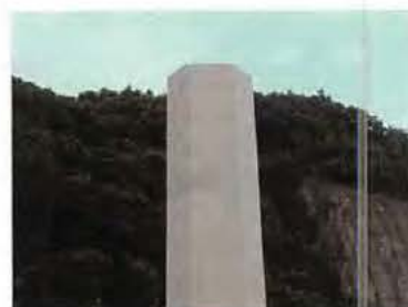
現在は茂菅の頭上に高架橋がかかっているが、当時は空が広がっていた。(当時は橋脚だけ)
