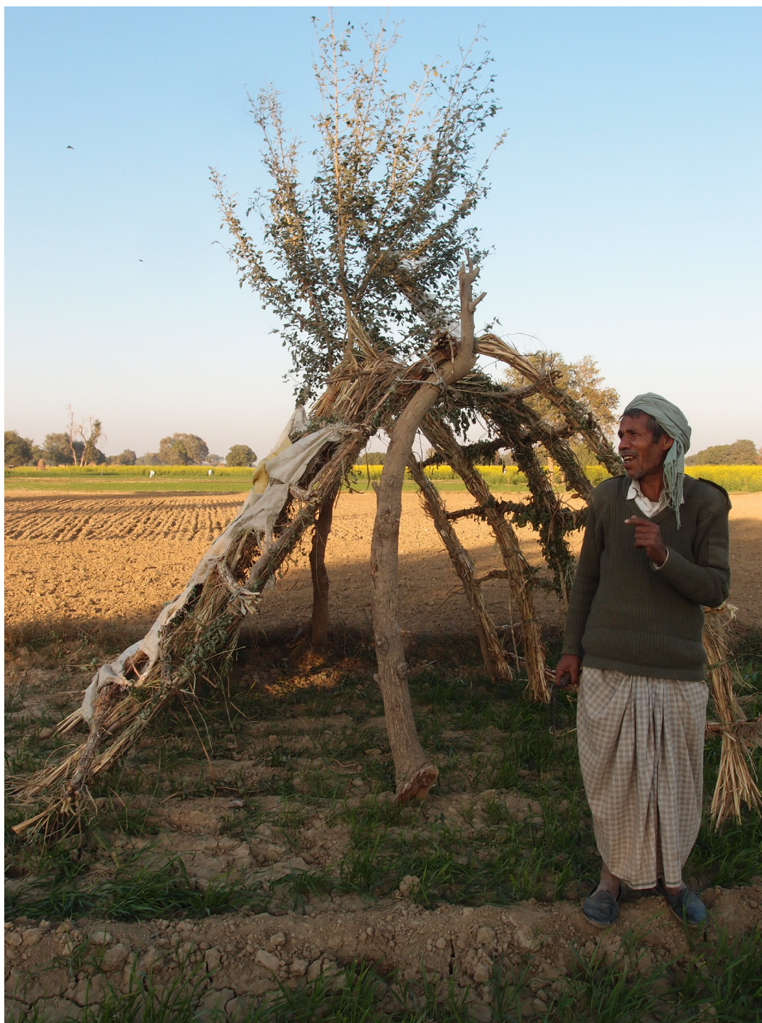
インドの建設中の物置（インド IND [マオリ、マツラ]）2017 棟持柱は生きている樹である。右の男性が建設者である。 Storage under construction of India (Mahoki, Mathura, India) Erika Koshi & Toshikazu Tsuchimoto, fieldwork, India, 2017
