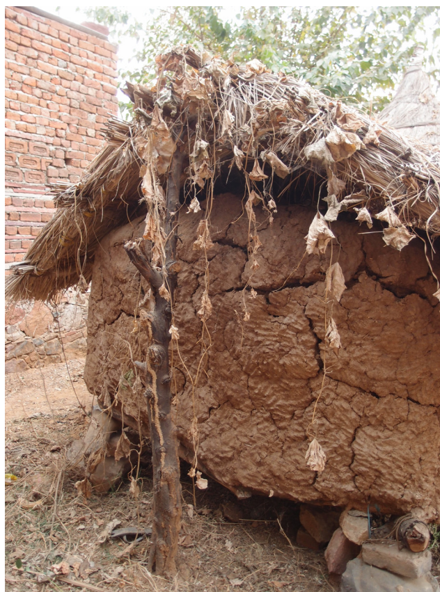
牛糞小屋（インド IND [ラーjesthan、チャンド バーオリー]）2017 二日間、天日干しした円板状の牛糞の塊を建物の隅々まで入れ込んである。壁は、牛糞を材料としている。 cow dung hut (Rajasthan, Chand Baori, India) Erika Koshi & Toshikazu Tsuchimoto, fieldwork, India, 2017
