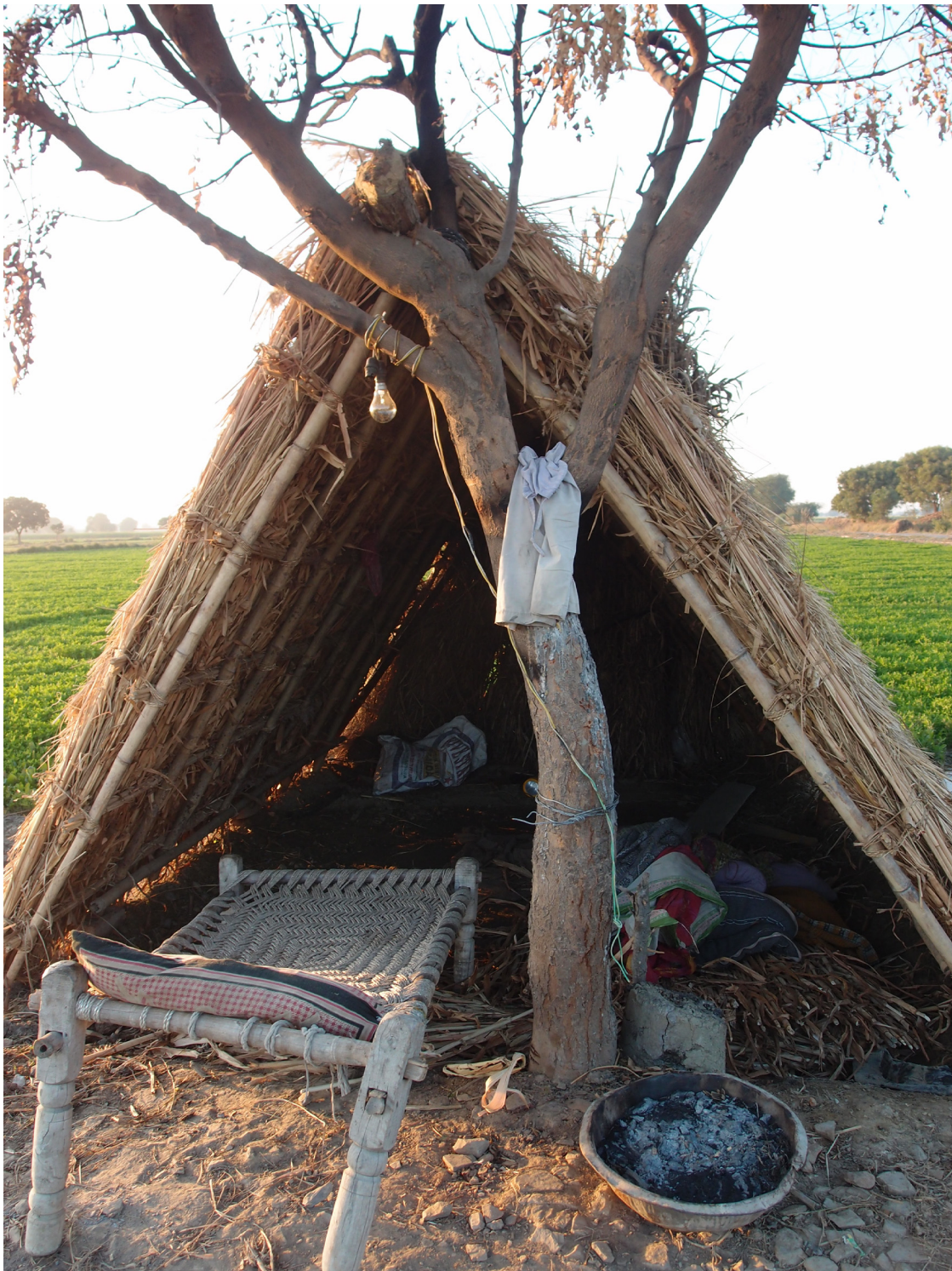
インドの作業小屋（インド IND [クリシュナ パティカ、布林ダバン]）2017 棟持柱は生きている樹であるが、根元で火を焚いているため、一部の枝が枯れ始めている。
