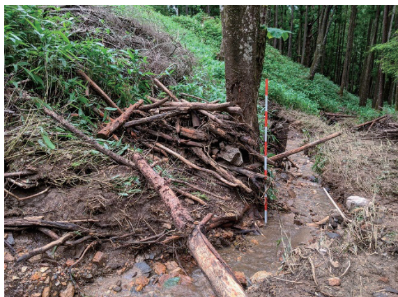
写真6 南側溪流の屈曲部における流木の堆積（作業道～観測地点 No.2 の区間）
