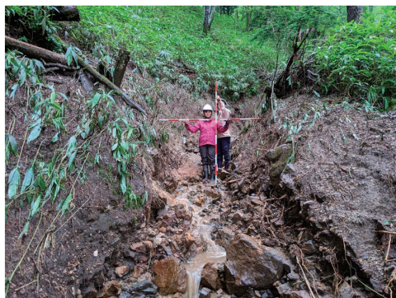
写真3 南側溪流の溪床の侵食と両岸斜面の流下痕跡（崩壊地～作業道の区間）
