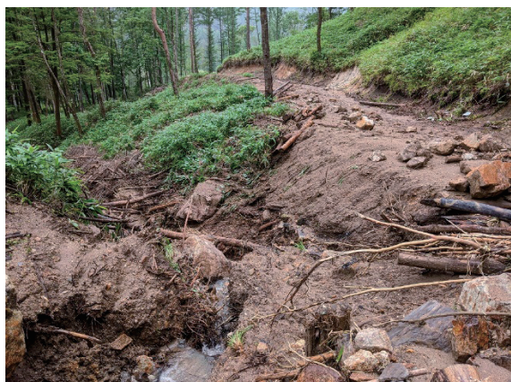
写真4 作業道における土砂と流木の氾濫堆積
