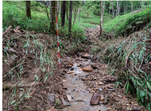
写真9 流下断面積調査地点 (流量観測地点 No.2 の上流20 m地点)
