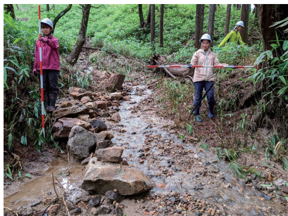
写真7 流量観測地点（図1, No.2）における土砂堆積
