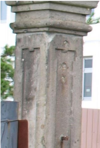
写真9 門扉とアーチ状の金具を取り付けた痕跡
