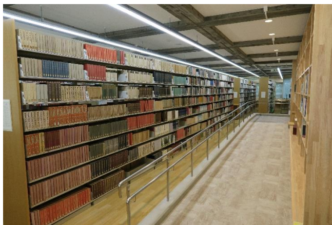
図2 改修後のスロープ、書架間のライン照明
