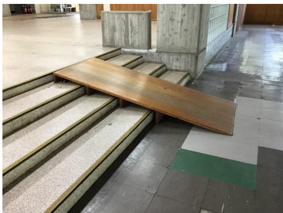
図1 改修前のスロープ
