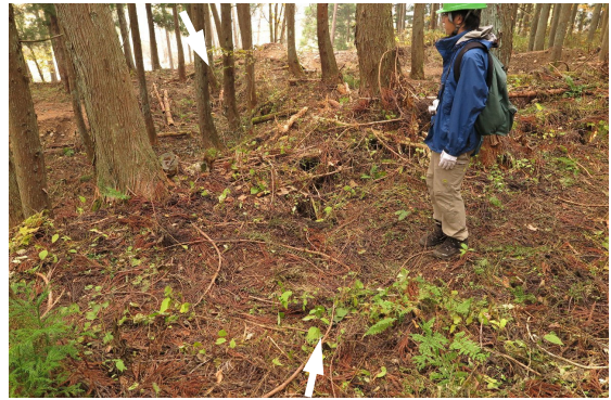
2-3-1 東側上昇の変位と開口亀裂
