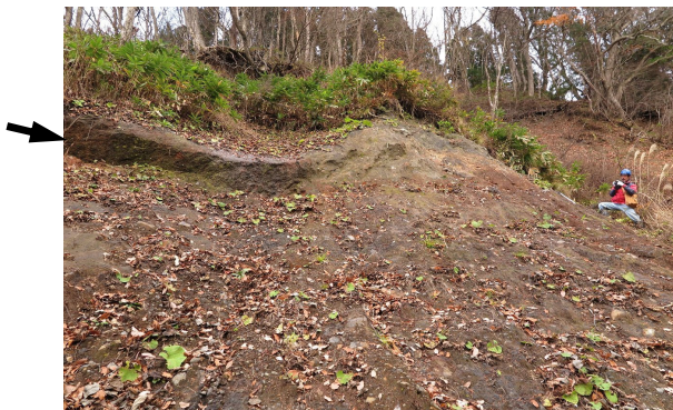
2-4-1 崩壊地に現れたひさし状に張り出した凝灰角礫岩中の断層面
