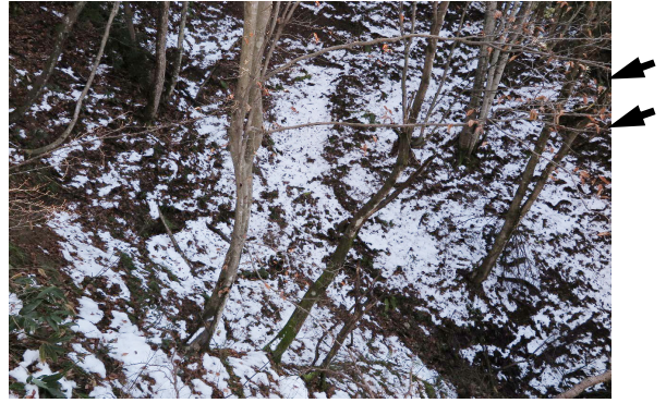
2-9-1 斜面に現れた2列の変状
