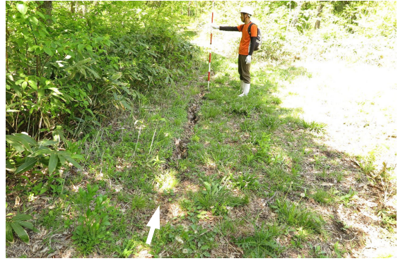
14-1-1 林道に生じた北側上昇を示す開口亀裂を伴う変状
