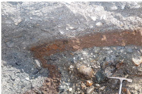
1-7-2 下水道補修作業で現れた東上昇を示す撓曲
