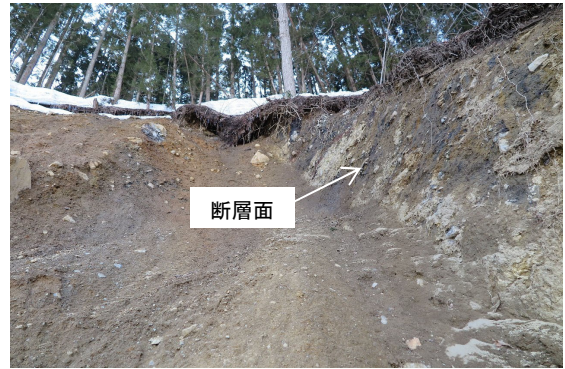
1-5-3 崩壊地に露出する断層面
