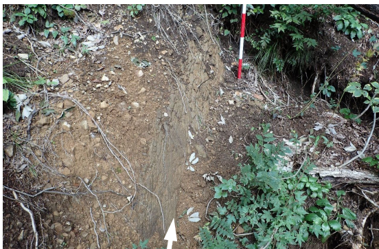
11-2-2 凝灰角礫岩中の条線を伴う東落ち正断層
