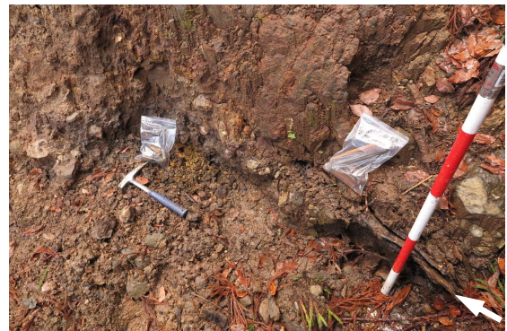
3-4-1 礫層中の断層
