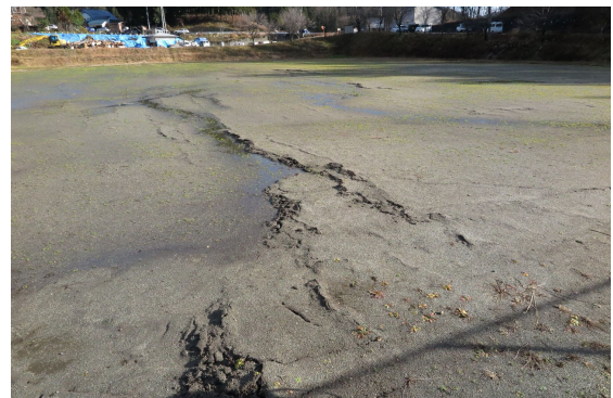
6-3-3 グラウンドに生じた北側上昇を示す変状
