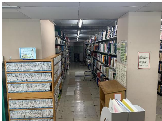
図1 改修前の閲覧室 積層書架が2階を支える
