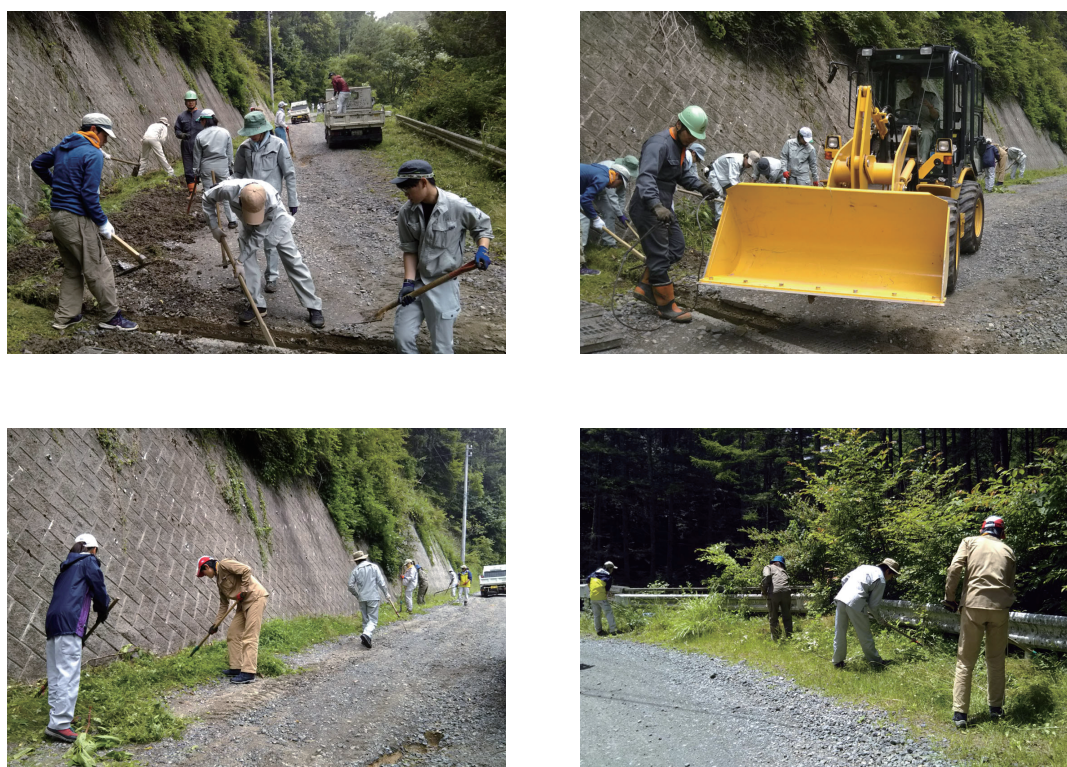
図3 作業の状況 上左：側溝と横断溝の浚渫，上右：重機での作業（グレーチング脱着，路面整備） 下左：側溝側の草刈，下右：ガードレール側路肩の草刈
