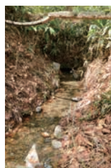
芋ノ田の横井戸 横井戸出口 明治の頃に掘削され約720mの地下水路 構内の農場の灌漑用水に利用されている
