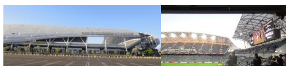
図11 Banc of California Stadium(ロサンゼルス FC)におけるETFEフィルムの屋根
