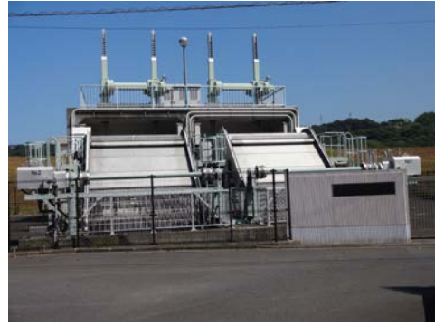
写真4 雨水排水ポンプ場
